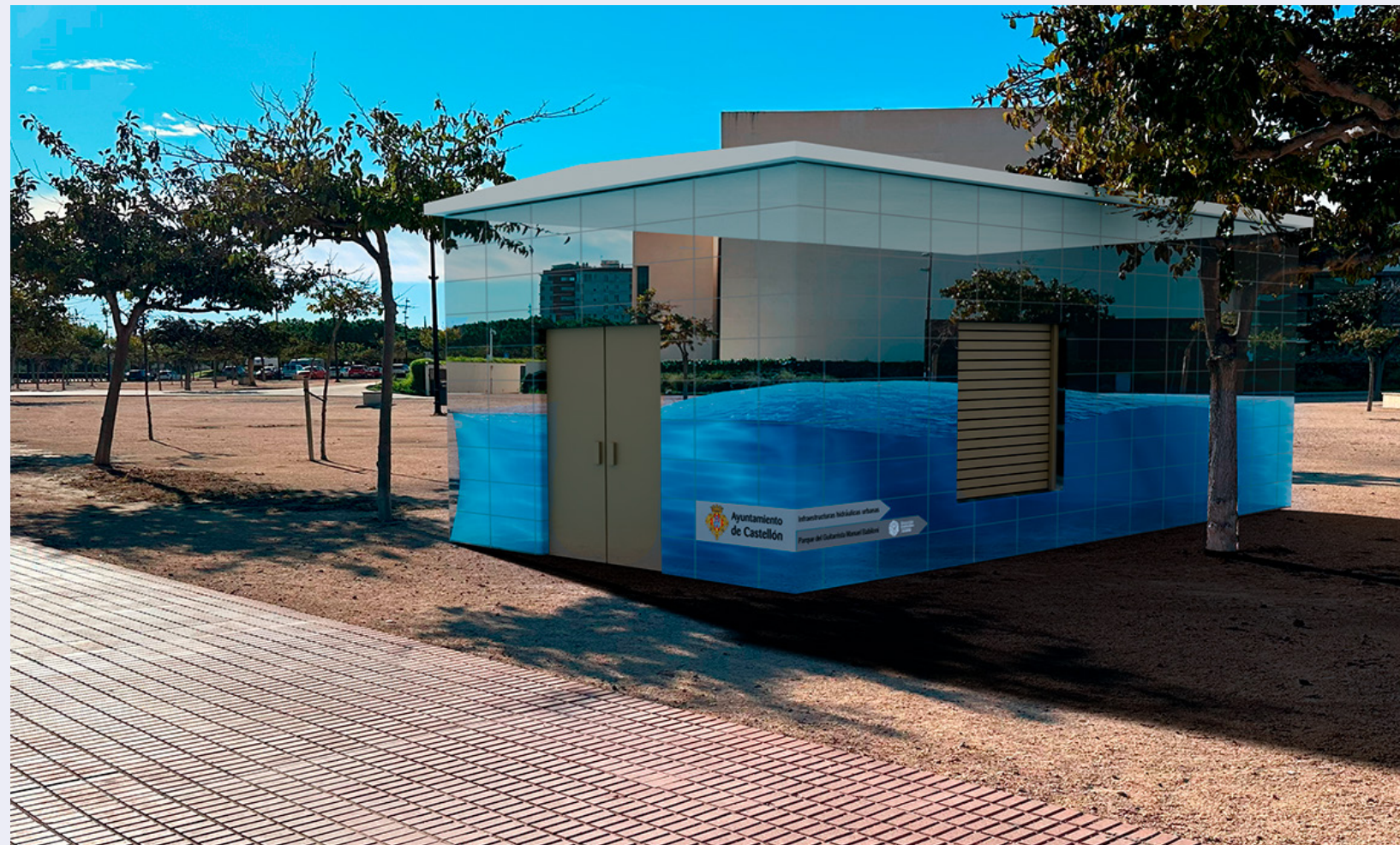
Infraestructuras hidráulicas urbanas EBAP Ronda Norte
