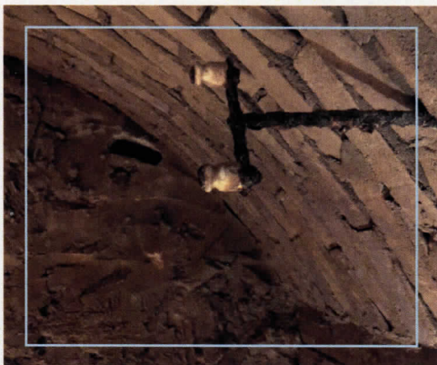
▲ Detalle de la instalación eléctrica del refugio. Arqueocas.
