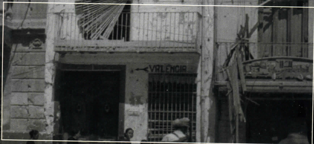
▲ Daños ocasionados por los bombardeos en los edificios del Pla. Fotografía tomada en junio de 1938. BNE.
